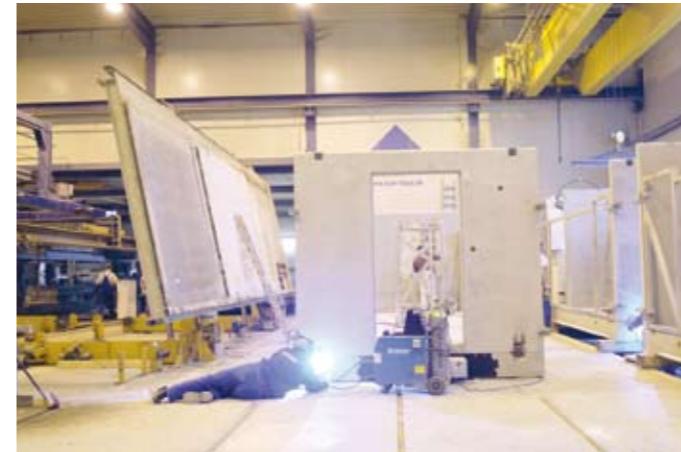
Modulares Bauprinzip: Wände, Decken und Installationen werden in Schlüsselfeld nach Kundenwunsch zusammengestellt, beim Haustyp „Icon“ auch der Innenausbau für Bad und Küche (rechts).
