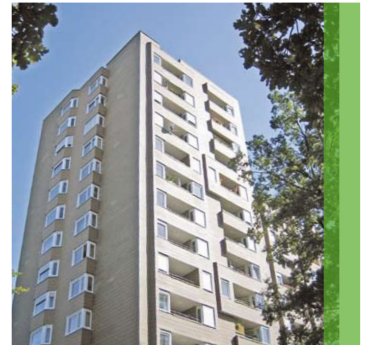
Brandschutzsicherheit auch für ältere Semester: Geprüftes Wohnhochhaus der LEG auf dem Stuttgarter Universitätscampus.
