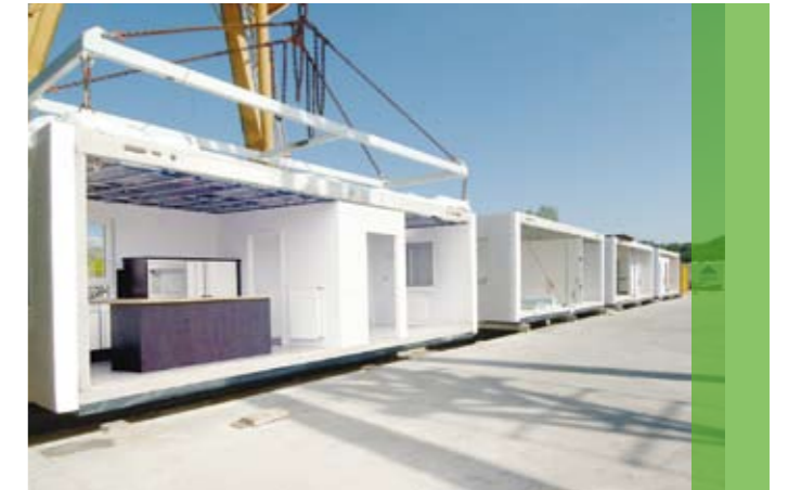
Modulares Bauprinzip: Wände, Decken und Installationen werden in Schlüsselfeld nach Kundenwunsch zusammengestellt, beim Haustyp „Icon“ auch der Innenausbau für Bad und Küche (rechts).
